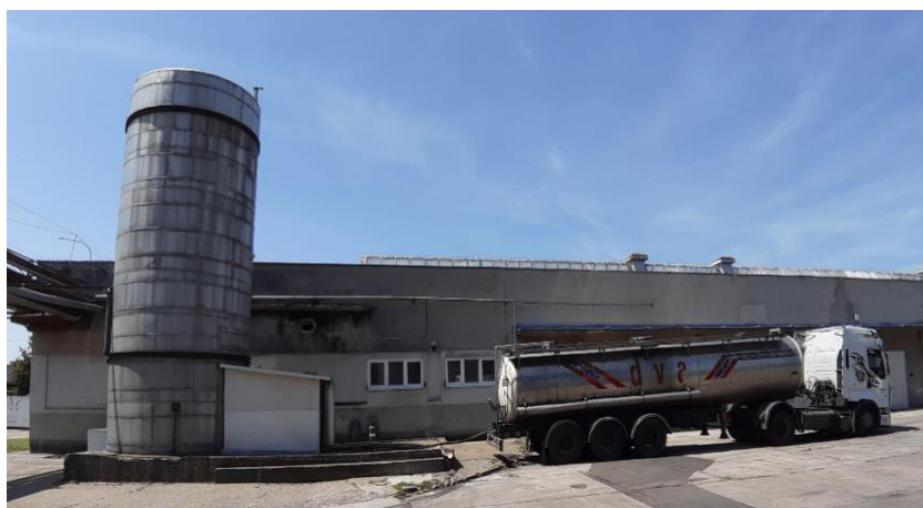
Obr. 9 Úschovná nádrž na srvátku s čerpacím zariadením a cisternou
